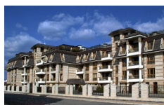
SIRENA RESIDENCE, Słoneczny Brzeg
